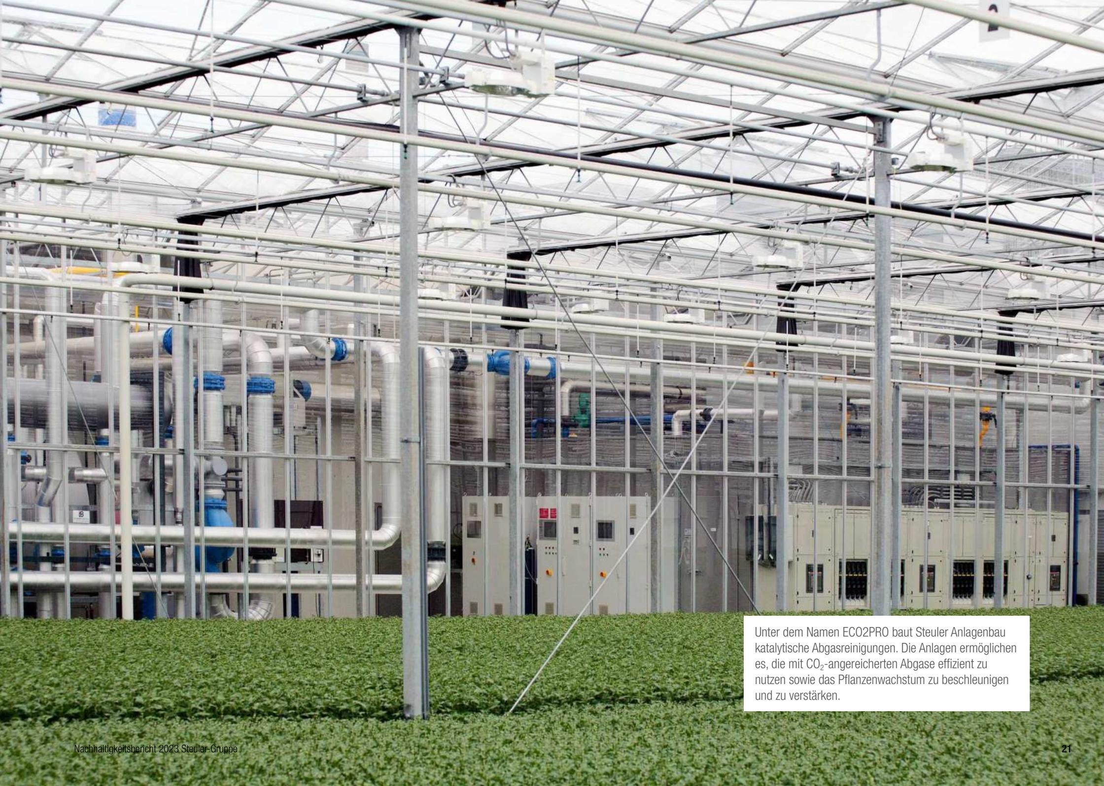
Unter dem Namen ECO2PRO baut Steuler Anlagenbau katalytische Abgasreinigungen. Die Anlagen ermöglichen es, die mit CO<sub>2</sub>-angereicherten Abgase effizient zu nutzen sowie das Pflanzenwachstum zu beschleunigen und zu verstärken.
