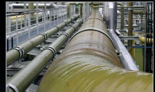
*Rohrleitungssystem aus PTFE/GFK in der chemischen Industrie.*
