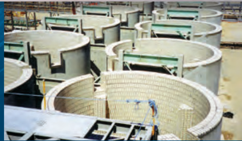
Bild oben: Beschichtete Reaktoren mit keramischem Verschleißschutz
