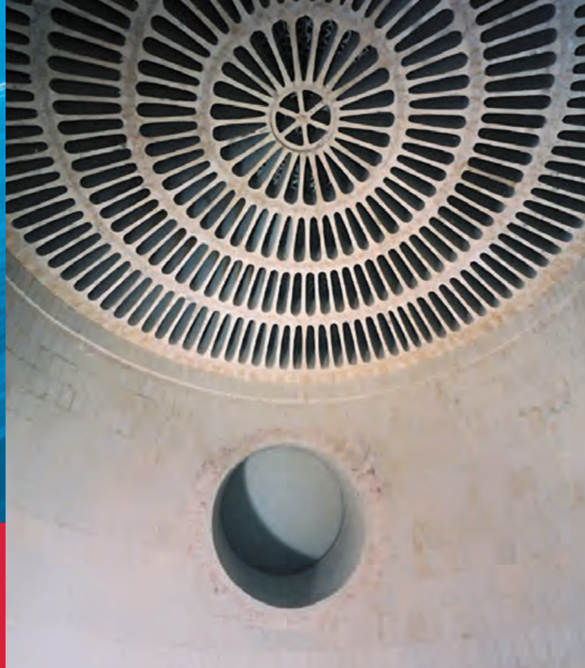
Bild oben: Gaseintrittsstutzen und darüber ein freitragender Steuler-Kuppelrost aus säurefestem Keramikmaterial
