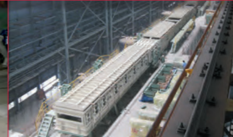
Bild oben: Montage einer komplett vorgefertigten Stahlbandbeizanlage
