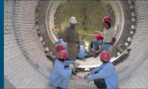
Bild unten: Ausmauerungen in Autoklaven und Flashvessel
