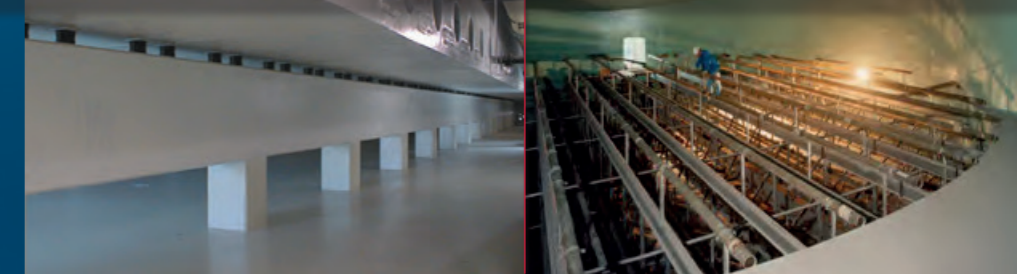
Unterhalb von Elektrolysezellen werden Tragkonstruktionen und Bodenflächen durch eine Polyurethanbeschichtung sicher geschützt.
