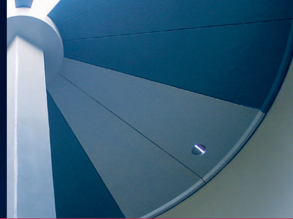
Bild rechts: Aufgespritzte Polyurethanbeschichtung in einem Prozessbehälter
