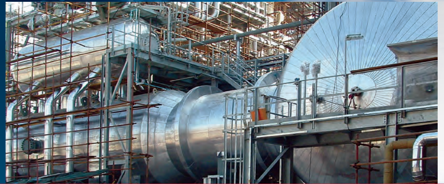
Bild unten: Schwefelsäure-Verbrennungsöfen
