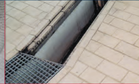
Bild unten: Mechanisch im Fundament verankerte Thermoplastrinnen mit speziellen Detaillösungen zur Anbindung an plattierte Industrieböden
