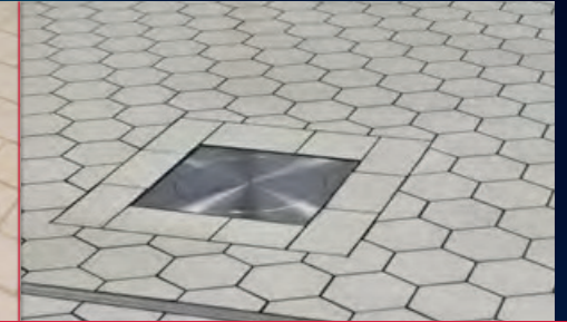
Bild unten: Auch Beläge in der Pharmaindustrie werden flüssigkeitsdicht verlegt und verfugt
