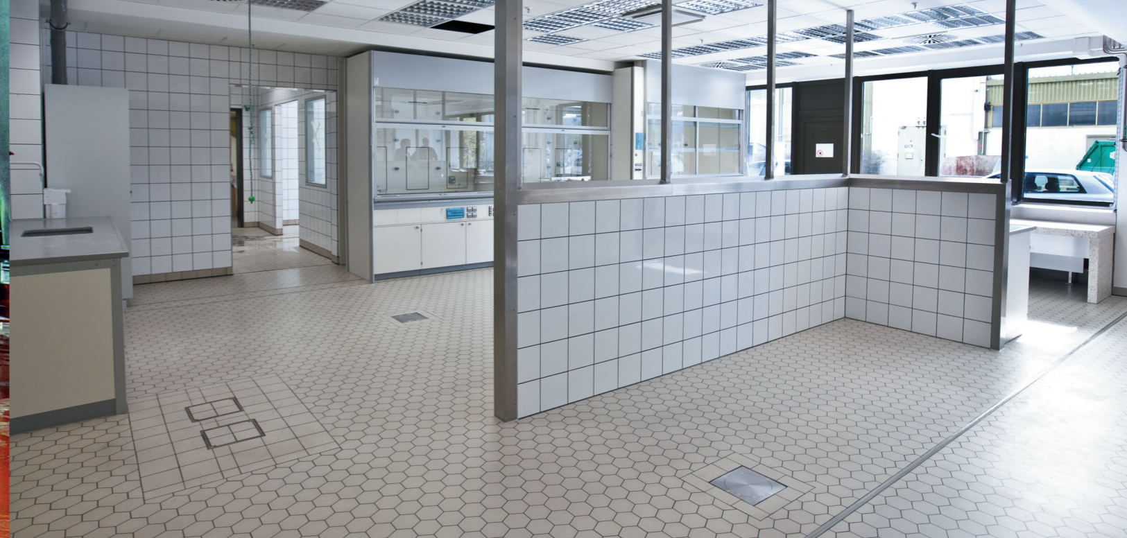
Selbstverlaufender Fußboden in der Lebensmittelindustrie: porenreich, leicht zu reinigen, sicher gegen aggressive Reinigungsmittel, mechanisch hoch belastbar.
