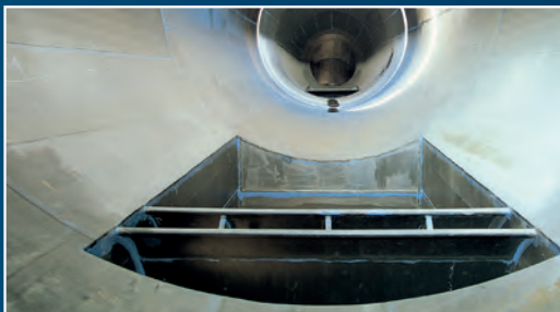
Gummierter Rohgaskanal. Auch Wärmetauscher, Quenche und Rohrleitungen können mit Steuler-Werkstoffen bis 150 °C sicher geschützt werden.
