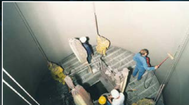
Dichtheitsprüfung einer Kamin-Beschichtung.
