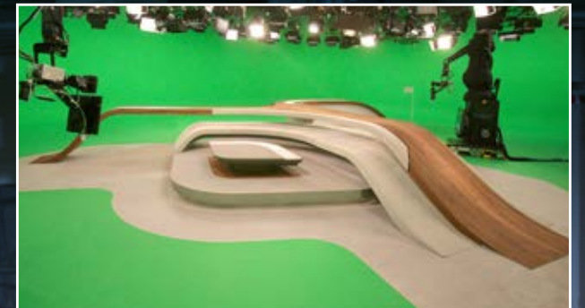
Bodenbeschichtung Spezial: Funktionsbeschichtung in einem Fernsehstudio.
