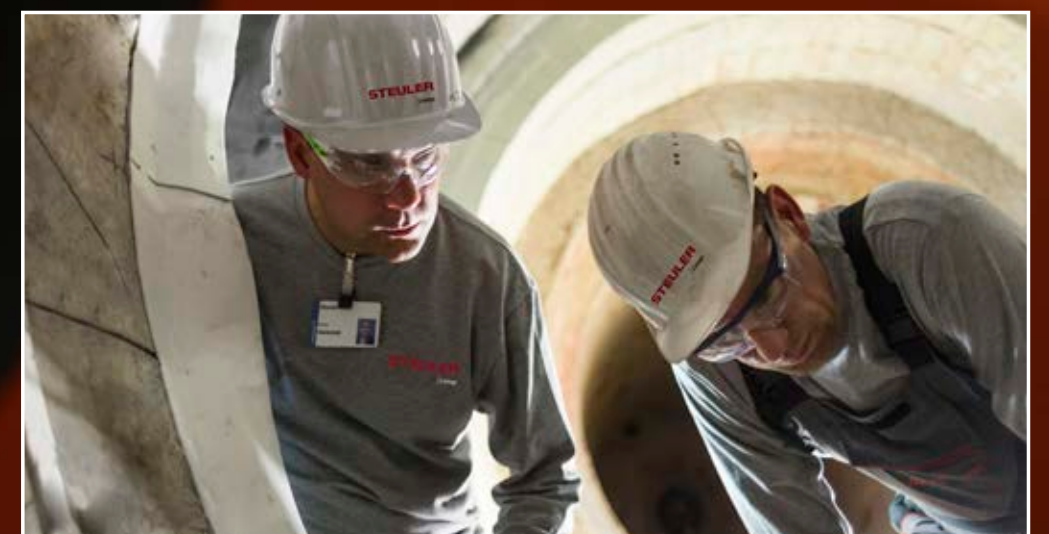
Ob Supervision oder Montage mit eigenem Fachpersonal – Steuler-Spezialisten stehen für eine verlässliche Installation.
