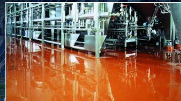
Bodenbeschichtung in einem chemischen Betrieb.
