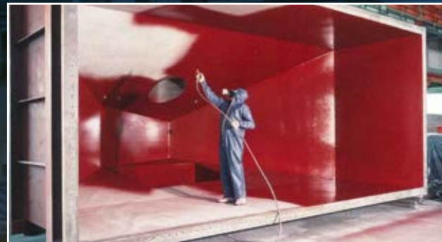
Spritzapplikation einer Beschichtung mit Barrierefüllstoffen.
