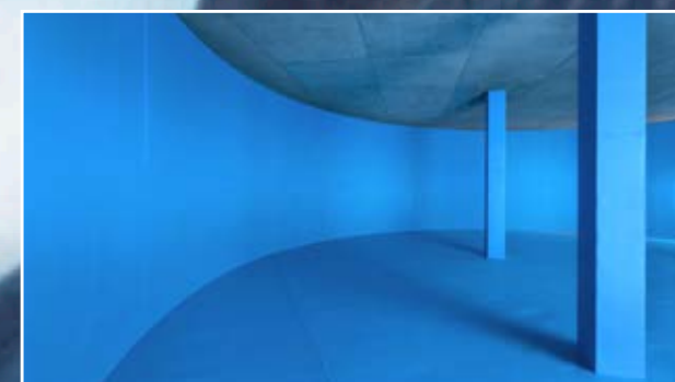
BEKAPLAST AQUA-LINING in einem Trinkwasserbehälter.
